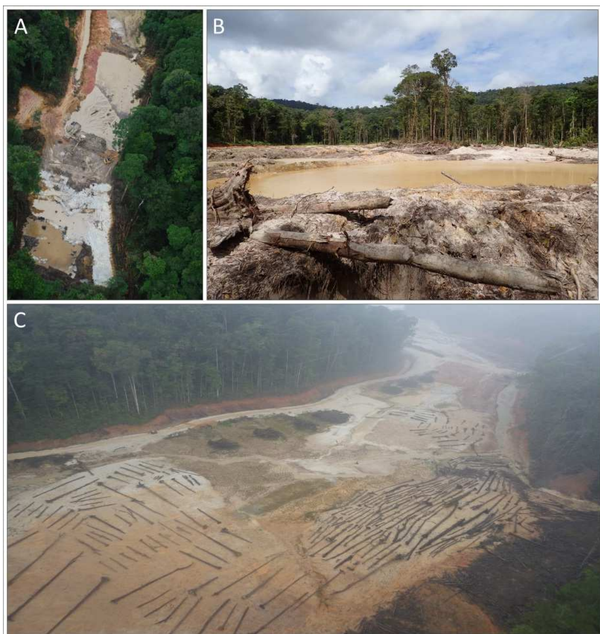
Figure 25 : Illustrations des impacts hydromorphologiques des mines alluviales en Guyane : fragmentations des milieux, destructions des cours d'eau et pollutions mécaniques (A © DGTM ; B © Le Bihan ; C © ONF).
