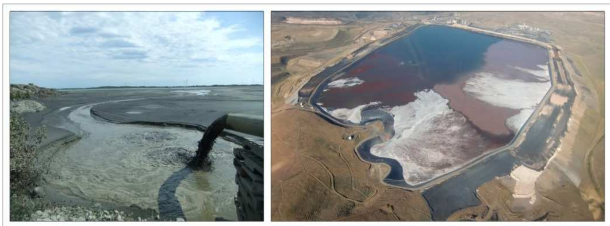
Figure 17 : Rejet de pulpe dans un parc à résidus à Rouyn-Noranda, Canada (à gauche, © Légaré) et illustration d'un parc à résidus sur la mine de Goldstrike, Nevada, USA (à droite, © Ecoflight).
