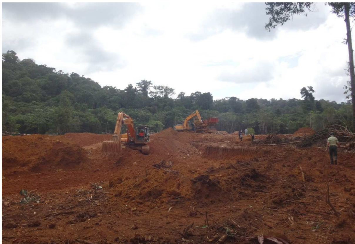
Travaux d'exploitation d'une mine aurifère alluviale en Guyane française (© DGTM).
