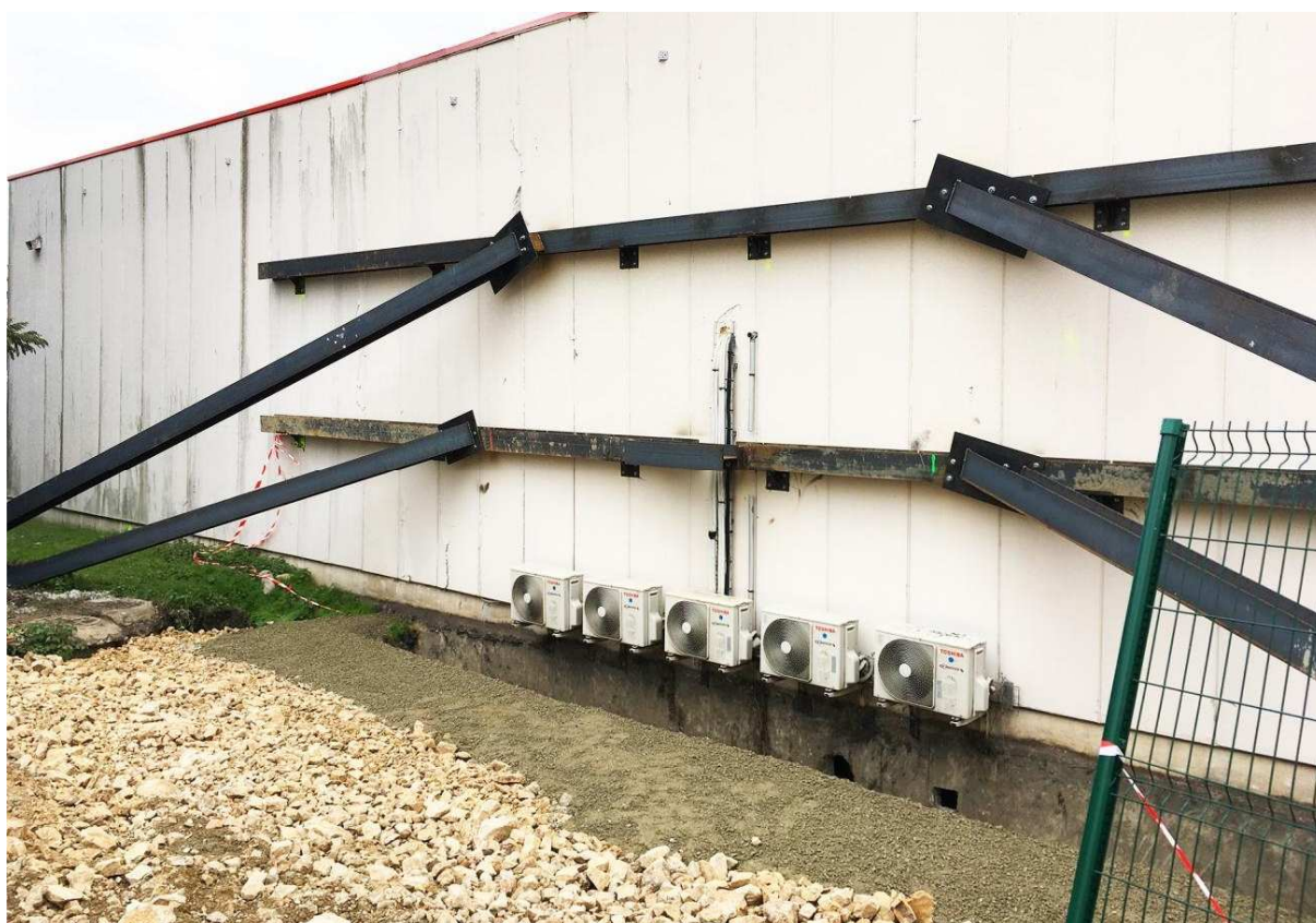
Figure 39 : Exemple d'intervention réalisée par le DPSM sur un fontis minier de près de 1 000 m 3 , apparu en mars 2021 à Saint-Étienne (en haut). La sécurisation du site (en bas) a été assurée en quelques semaines (© J.-L. Nédellec - BRGM).
