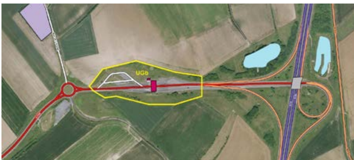
Figure 111 : Cas n°2 : vue aérienne de l'échangeur autoroutier au Boulonnais
