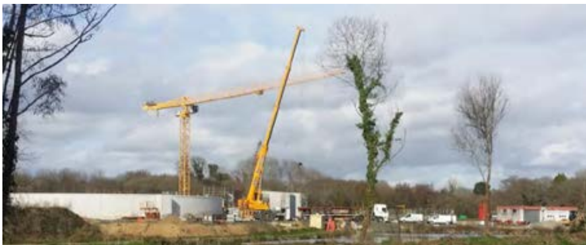
Figure 16 : Photo du chantier de la station d'épuration de Fouesnant
