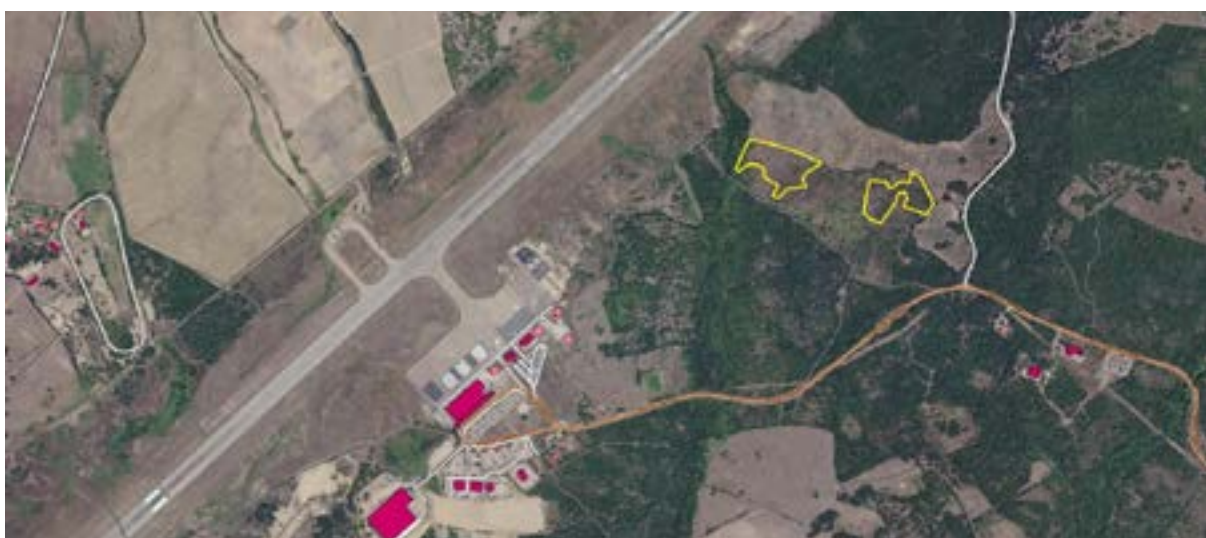
Figure 6 : vue aérienne du projet de centrale de production d'électricité photovoltaïque à Figari
