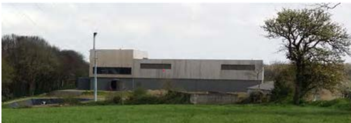
Figure 3 : photo de la chaufferie industrielle
