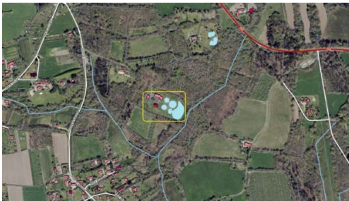
Figure 14 : Vue aérienne de la station d'épuration à Combrit
