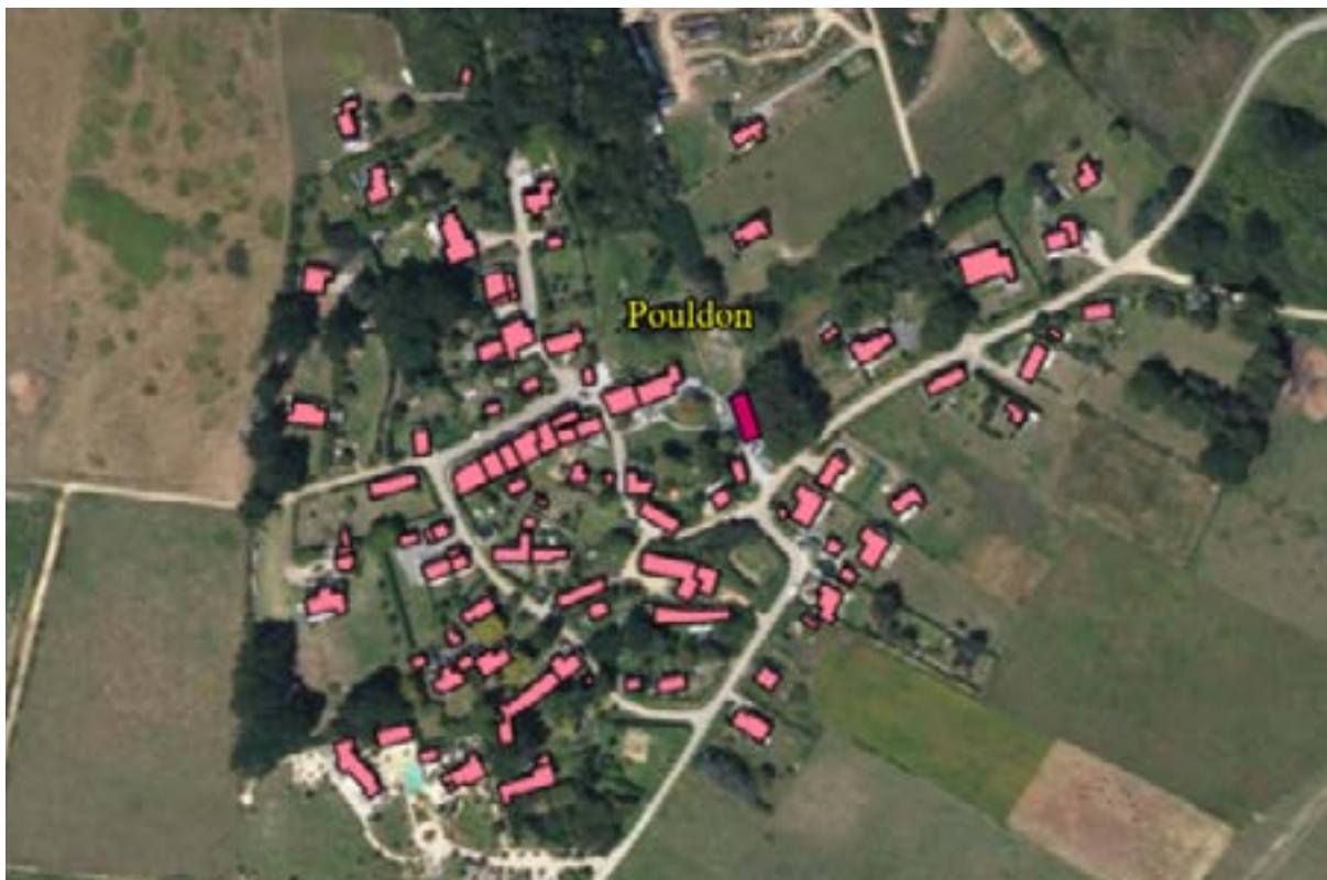
Figure 58 : vue aérienne du lieu-dit Pouldon à Locmaria
