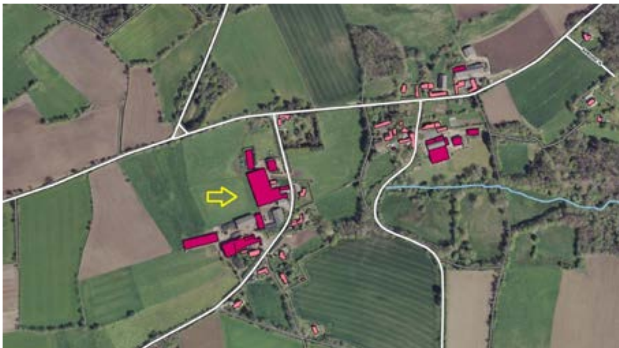
Figure 28 : vue aérienne de l'emplacement du projet à Poullan/Mer
