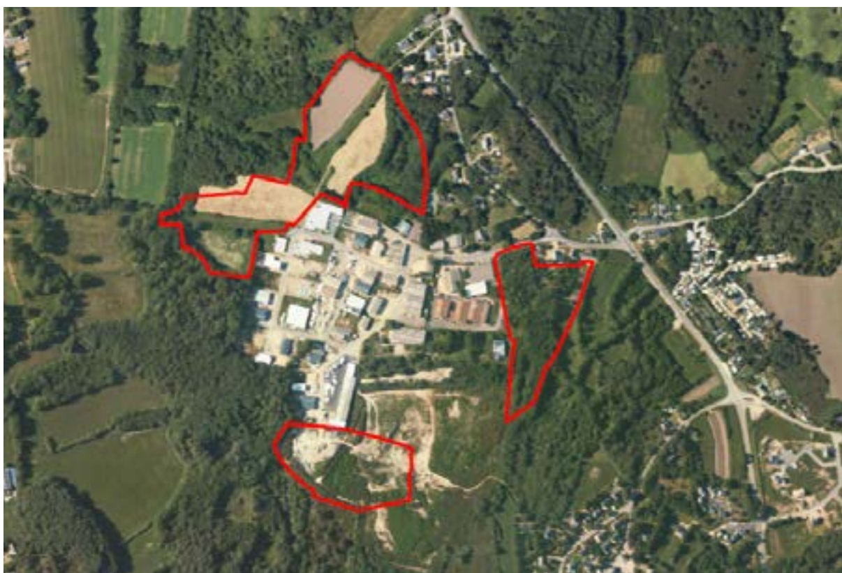
Figure 88 : En rouge, les parcelles où l'extension de la zone d'activité a été autorisée par le juge (DDTM 56)
