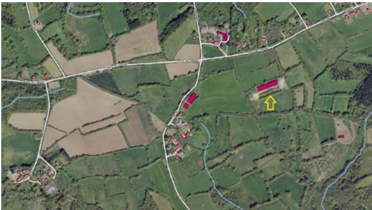
Figure 18 : vue aérienne du projet d'extension d'un poulailler à Logonna-Daoulas
