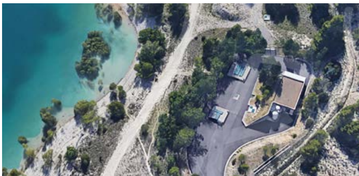
Figure 31 : vue aérienne de la station de pompage de Pradelle à Moustiers-Sainte-Marie
