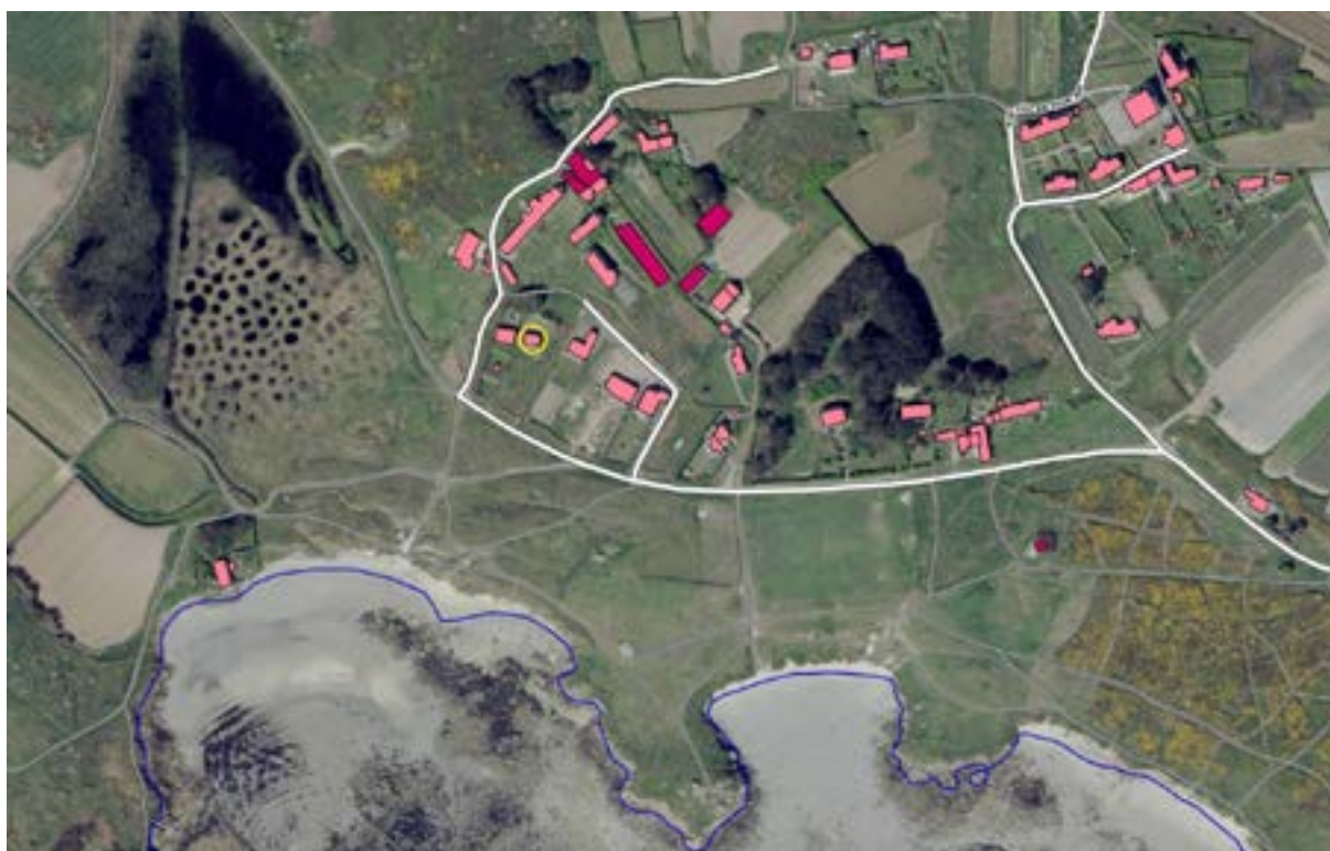
Figure 25 : vue aérienne de l'emplacement du projet d'extension d'une construction existante à usage d'habitation sur l'Île de Batz
