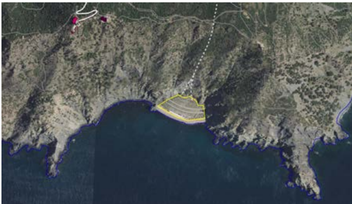
Figure 13 : vue arienne de la station d'épuration du Cap Sicié
