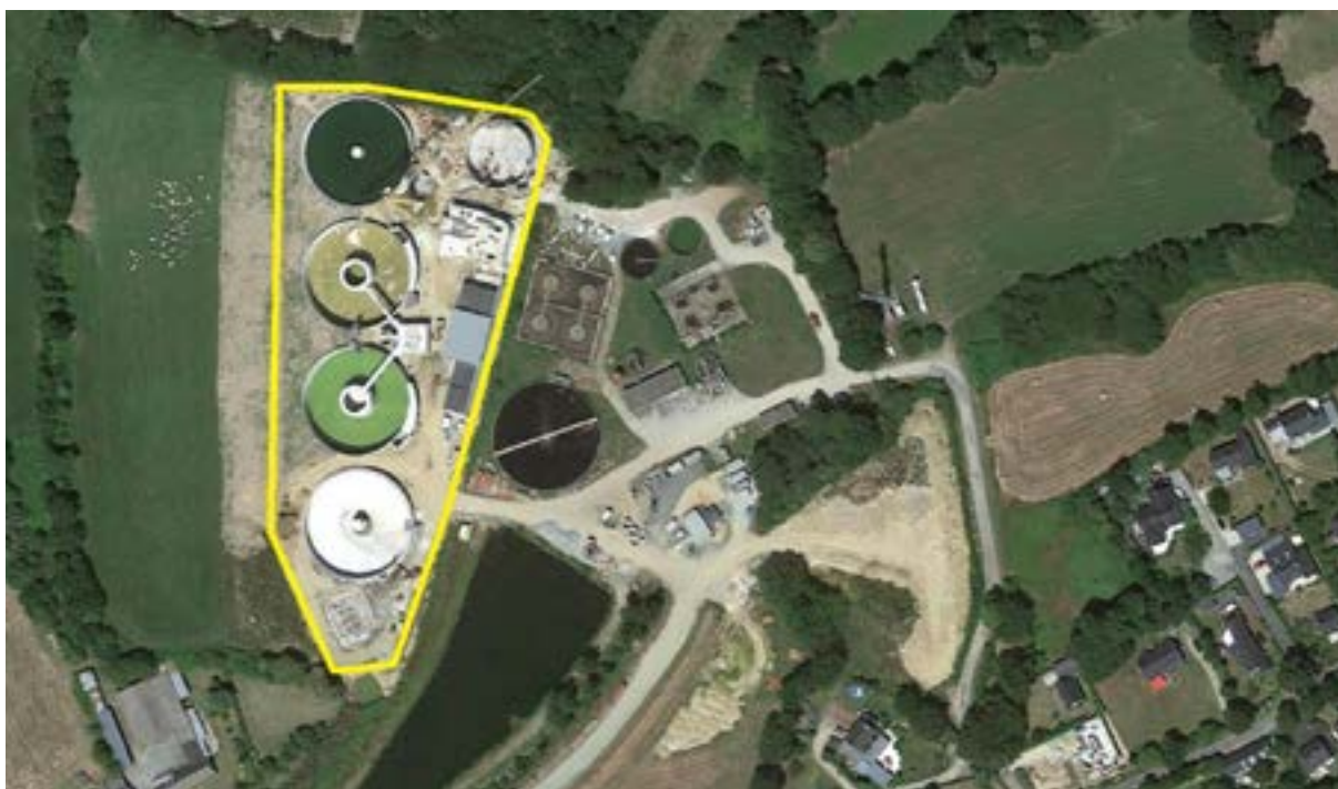
Figure 17 : vue aérienne de la station d'épuration de Fouesnant
