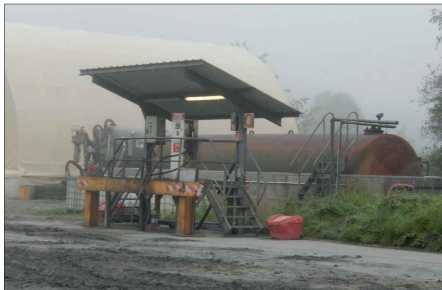
Ravitaillement sur aire étanche
