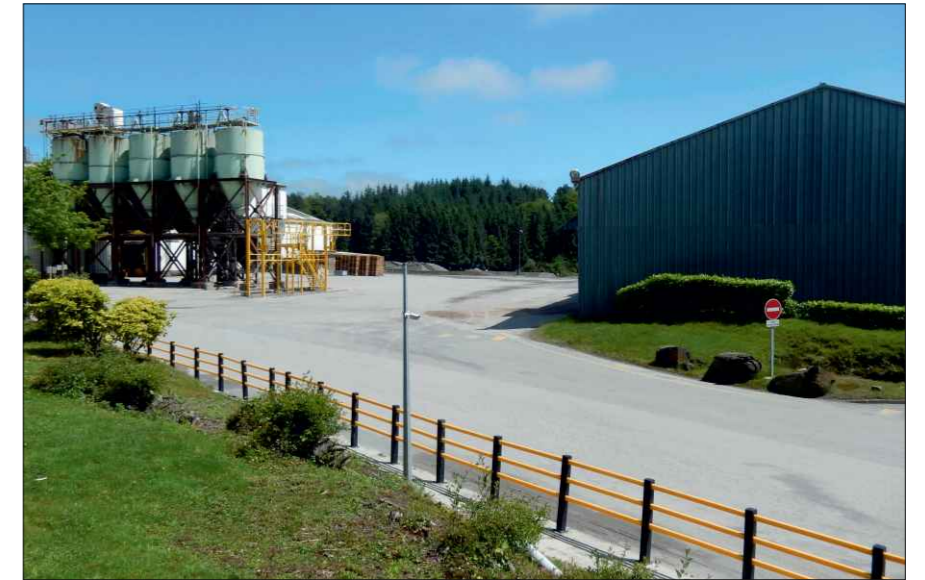
Aménagements paysagers + piste en enrobés sur la plateforme
