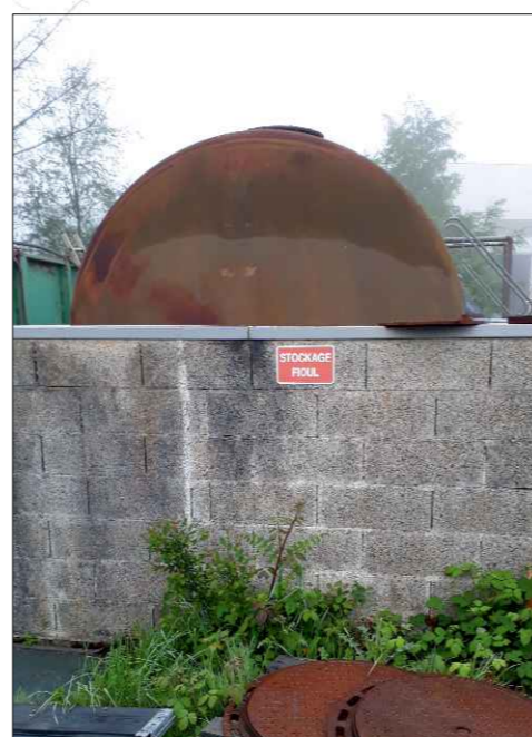
Cuve de carburant sur rétention
