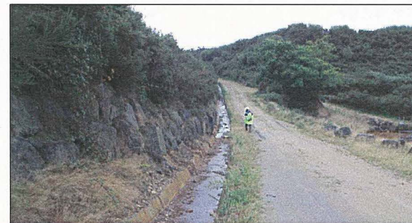
Photo 3 : Tranchée de drainage au pied de la verse
