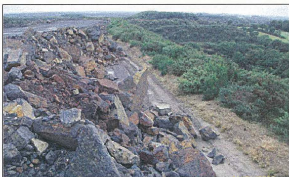
Photo 2 : Protection du talus libre par les matériaux rocheux
