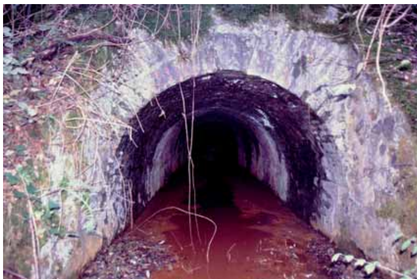
Fig. 2-10 : Ancienne mine de plomb-zinc : drainage minier acide à la sortie d'une galerie, pH 2 à 3 (photographie J. Féraud, Brgm)
