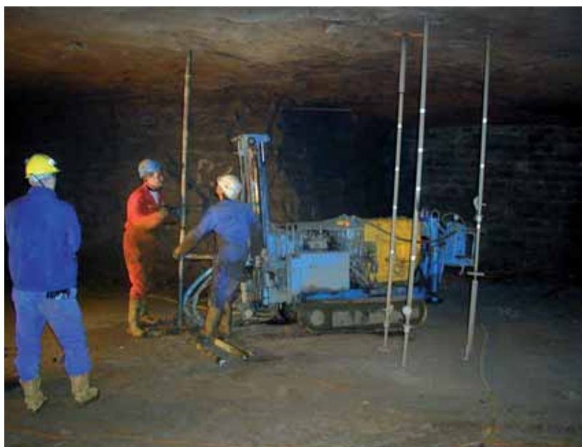
Fig. 3-11 : Mise en place de cannes de convergence (pilote de Tressange, mines de fer de Lorraine) photo Brgm.
