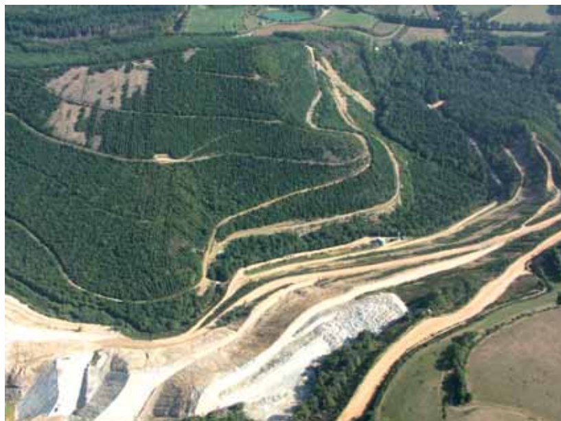
Fig. 2-20 : Réaménagement ancien de la partie nord de la mine de fluorine à ciel ouvert du Moulinat (St-Jean-de-Jeanne, Tarn) (photo P. Bretin 2001, SOGEREM/ALCAN).
