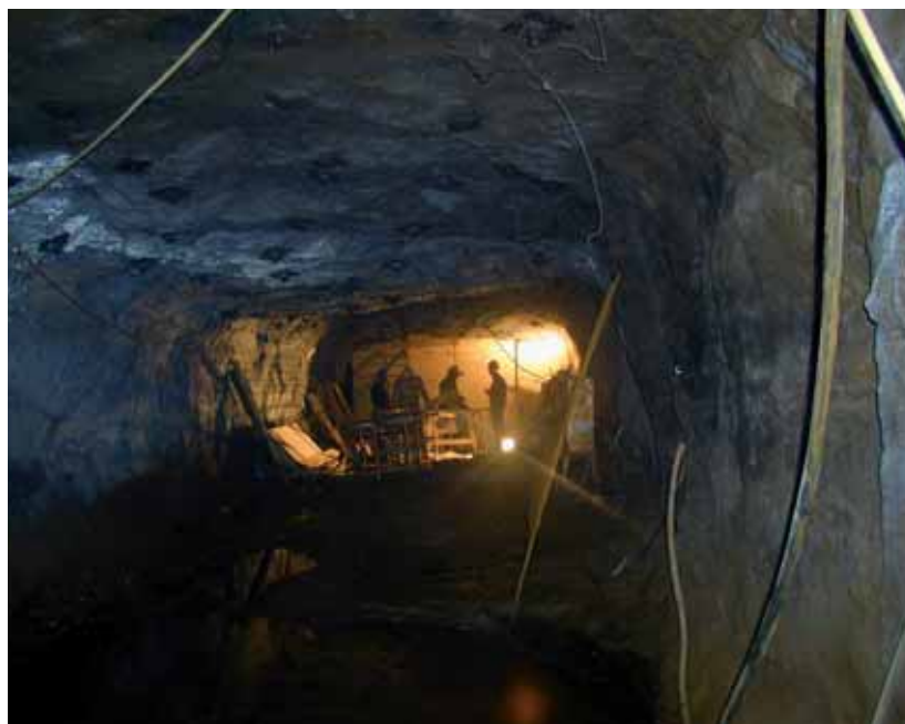
Construction des barrages du site pilote de Tressange (mines de fer de Lorraine) photo Brgm
