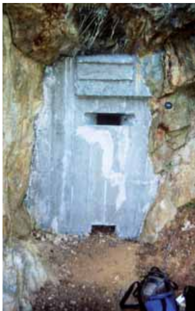
Fig. 3-3 : L'ouverture du haut laisse passer les chauves-souris (faune protégée) et celle du bas la petite faune rampante ou l'eau. Ce type de bouchon en béton armé, large d'un mètre, est la bête noire du collectionneur de minéraux (Peisey, photo Féraud).
