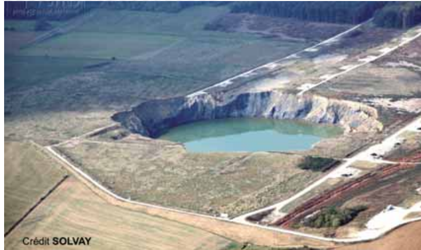
Fig. 3-13 : Effondrement provoqué d'une cavité de dissolution dans le sel en Lorraine (concession Solvay), photo Solvay.
