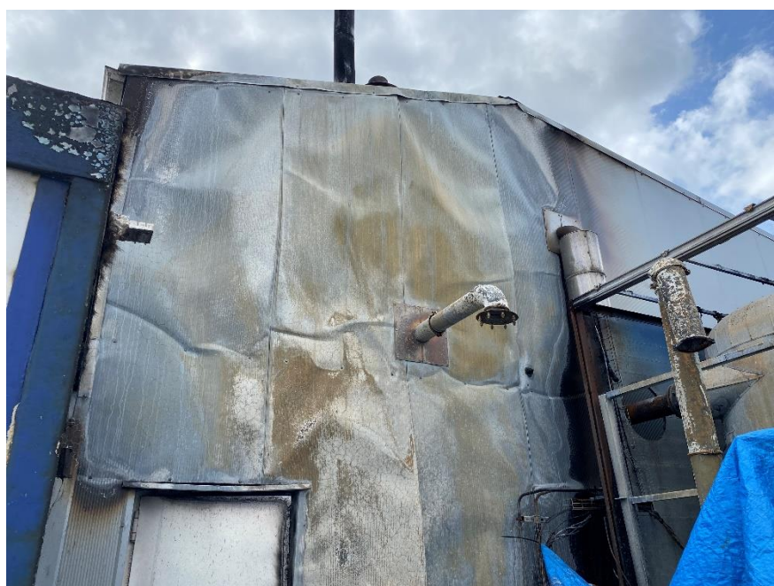
Figure n°2: façade extérieure du bâtiment principal de l'UDP
