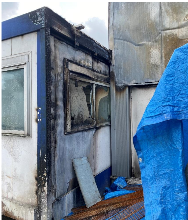
Figure n°3 : façade du bungalow attenant au bâtiment principal de l'UDP
