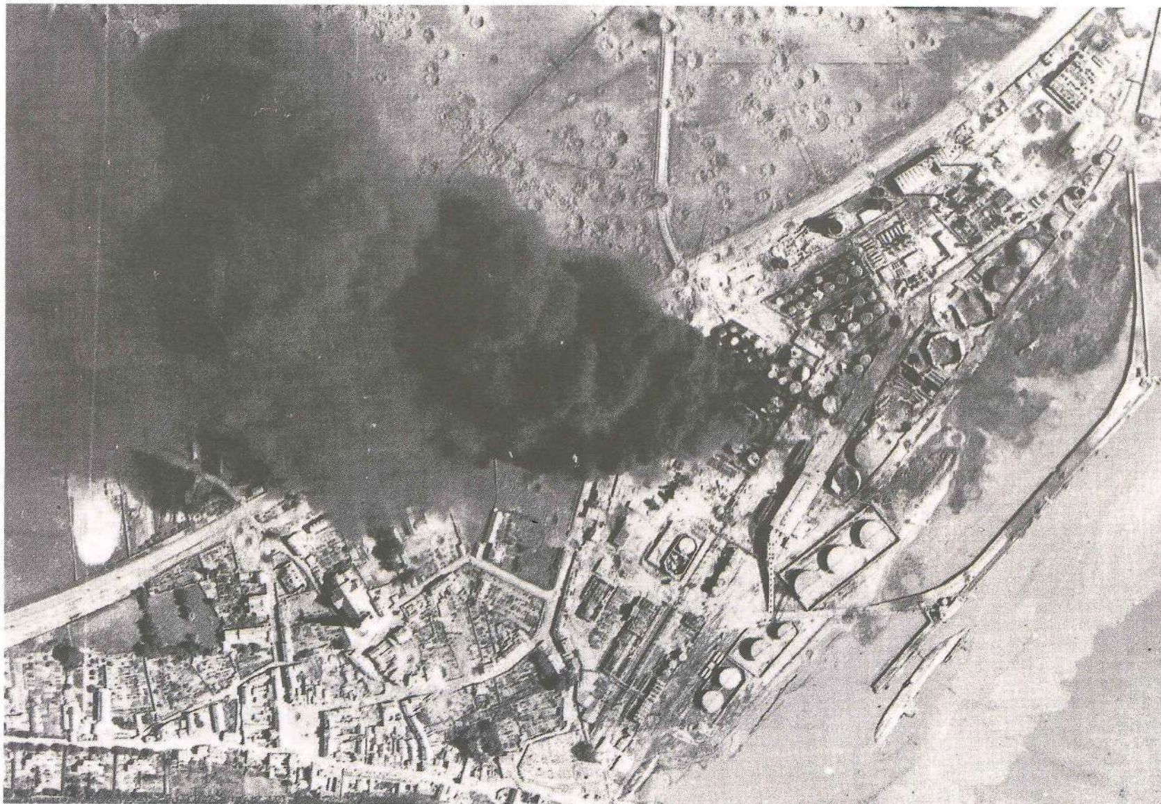
La raffinerie a subi de nombreux bombardements qui n'ont pas épargné le bourg, dont les plus violents eurent lieu en 1944.
