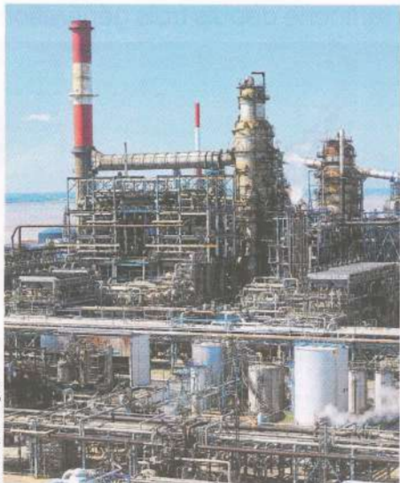
Dans la première étape du raffinage, pour trier des molécules d'hydrocarbures, on chauffe le pétrole brut dans une tour de distillation (en arrière-plan sur la photo).
