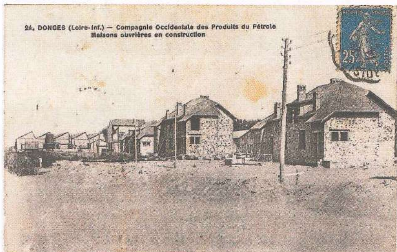
Pour loger les travailleurs, des maisons ouvrières sont construites à proximité des entrepôts de produits pétroliers.
