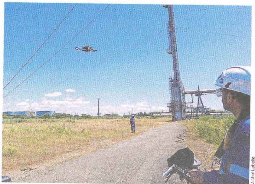
La raffinerie utilise des drones pour inspecter les torches.
