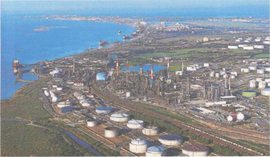
La raffinerie Total de Donges est la seule située sur la façade Atlantique.
