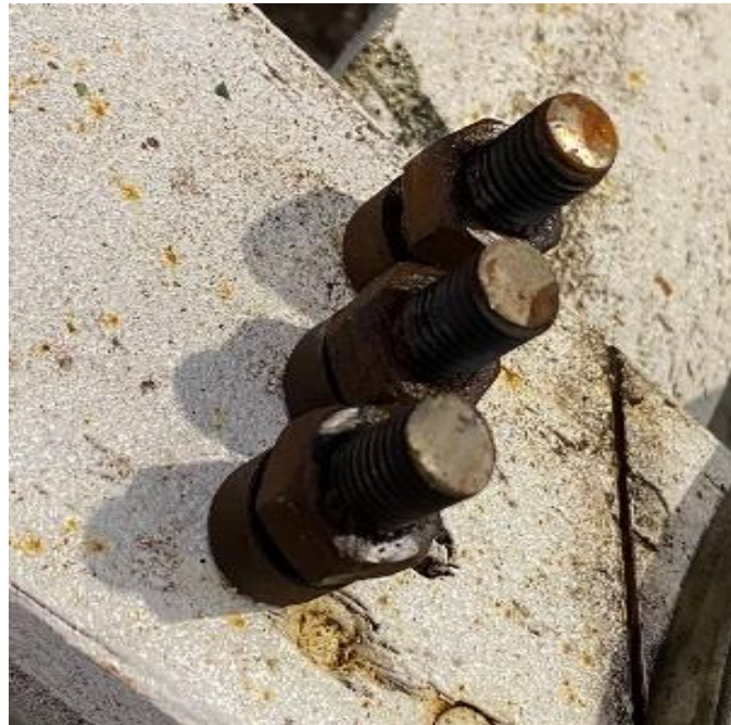
Figure 19 : vis à bouts plats
