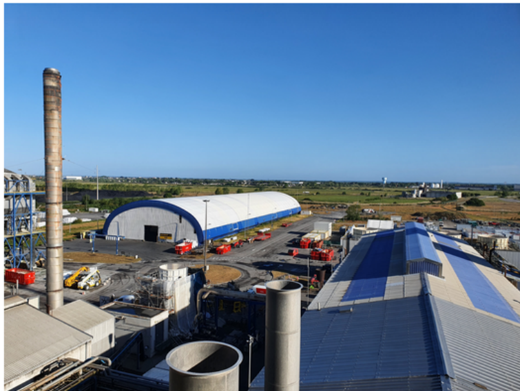
FIGURE 1.11 – Site de Yara à Montoir-de-Bretagne Source : site de Yara France ( https://www.yara.fr/ )
