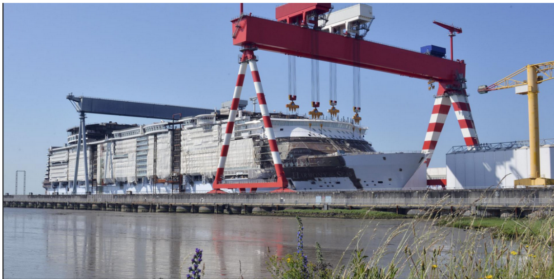
FIGURE 1.9 – Chantiers de l'Atlantique à Saint-Nazaire. Source : site web de l'office de tourisme de Saint-Nazaire ( https://www.saint-nazaire-tourisme.com/ )
