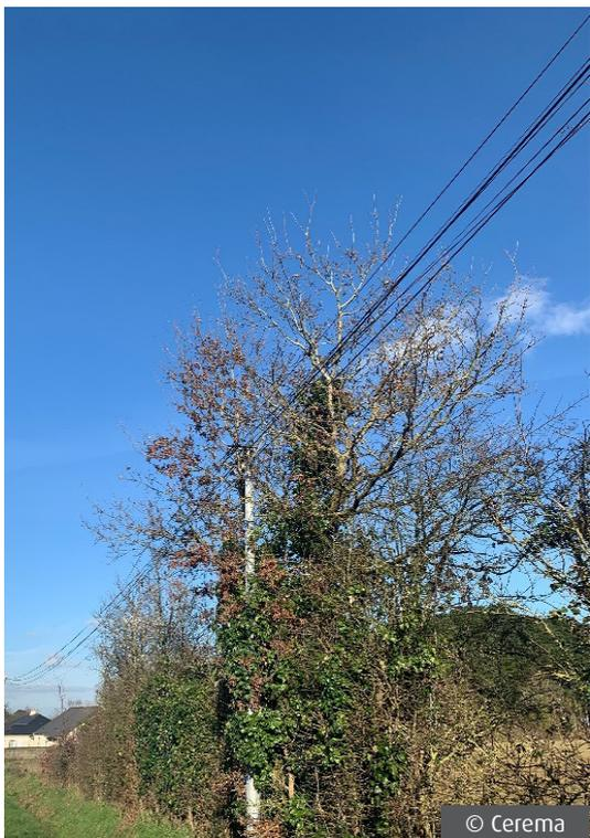
Câble de raccordement d'abonnés en zone rurale pris dans les arbres
