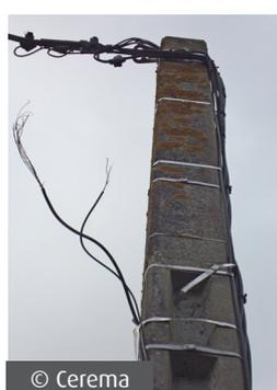
Le PC (boîtier de raccordement des usagers du cuivre) a été arraché
